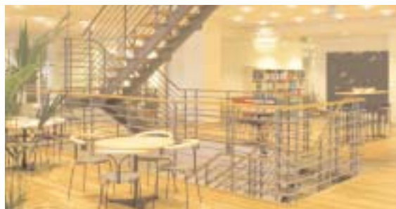
FÖR ATT SLÄPPA IGENOM SÅ MYCKET LJUS SOM MÖJLIGT HAR TRAPPAN INGA SÄTTSTEG. TRAPPSTEGEN ÄR AV 40 MM MASSIV OLJAD EK.
