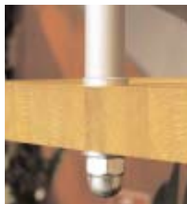
SAMMANLAGT 70 M TRAPPRÄCKE AV SILVERFÄRGAT STÅLRÖR LEVERERADES SOM BYGGSATS OCH BEHÖVDE BARA MONTERAS PÅ PLATS. TRAPPSTEGEN ÄR AV 40 MM MASSIV OLJAD EK.
