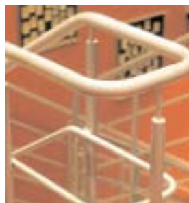
SAMMANLAGT 70 M TRAPPRÄCKE AV SILVERFÄRGAT STÅLRÖR LEVERERADES SOM BYGGSATS OCH BEHÖVDE BARA MONTERAS PÅ PLATS. TRAPPSTEGEN ÄR AV 40 MM MASSIV OLJAD EK.
